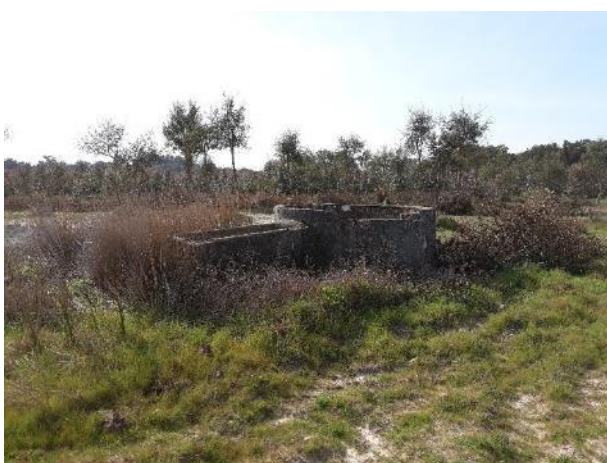
Fotografia 5.5 – Captação de água subterrânea (poço) na área de estudo.
