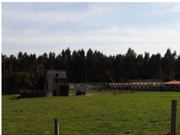
Fotografia 5.9 – Captação de água subterrânea na área de estudo.
