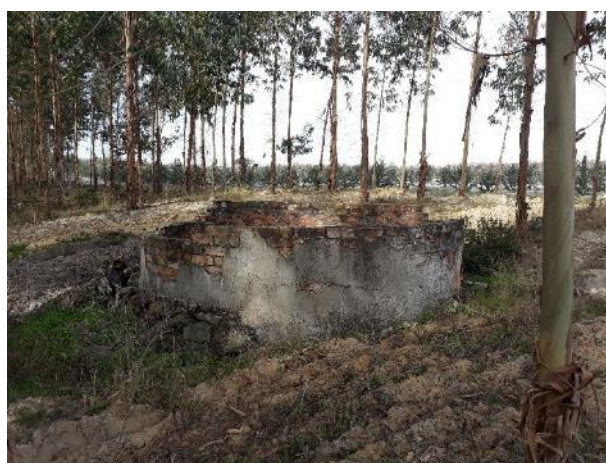
Fotografia 5.6 – Captação de água subterrânea (poço) na área de estudo.
