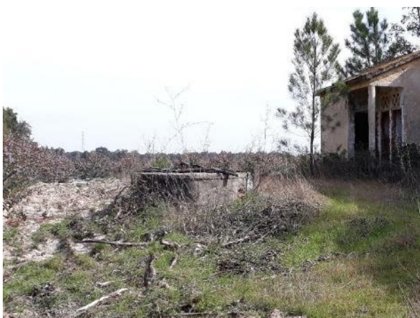
Fotografia 5.7 – Captação de água subterrânea (poço) na área de estudo.
