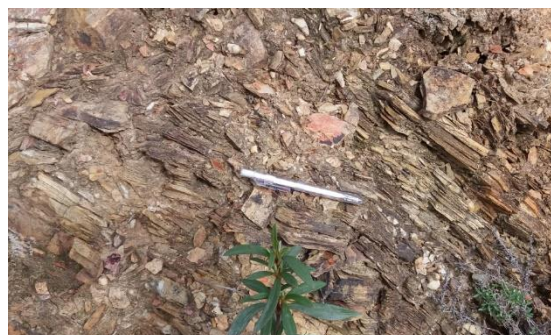
Pormenor do talude de escavação observando-se fragmentos de grauvaque e xisto da formação turbidítica em leitos milimétricos, muito alterados
