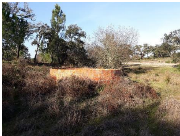
Fotografia 5.10 – Captação de água subterrânea (poço) na área de estudo.
