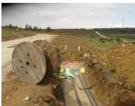
Fotografia 4.8 – Exemplo de vala para instalação de cabos elétricos.
