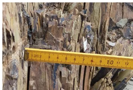
Pormenor das bancadas milimétricas a centimétricas, com inclinação sub-vertical, muito alteradas. Identificaram-se duas direções de fraturação muito próximas (N40W e N45W)
